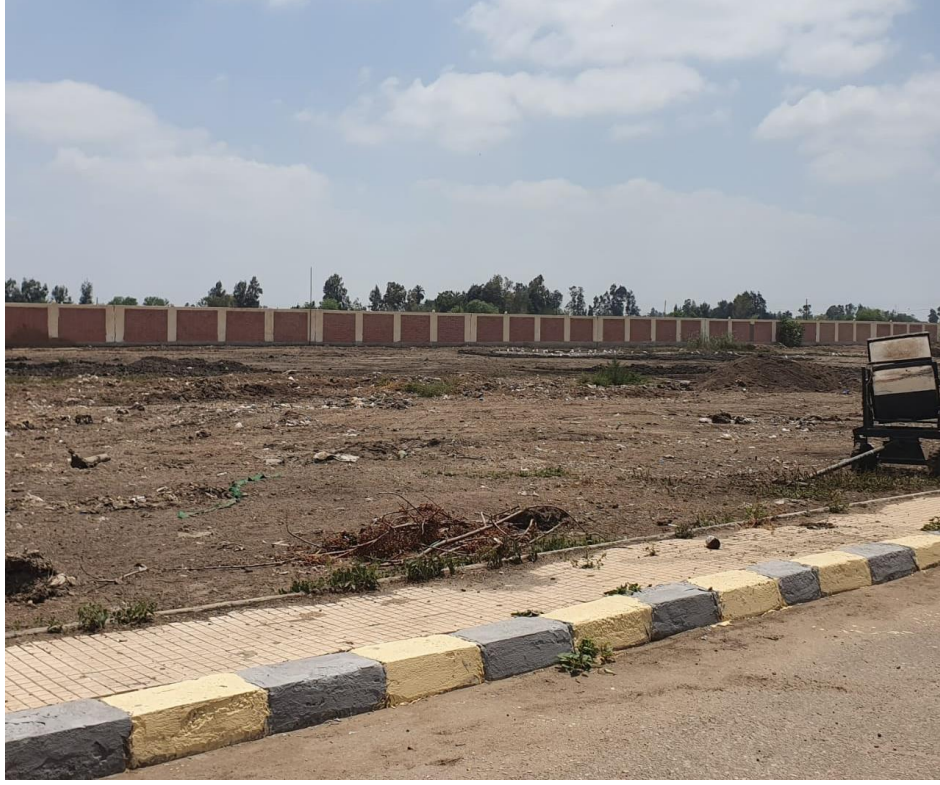
شكل ١٠ : موقع محطة معالجة الصرف الصحي
