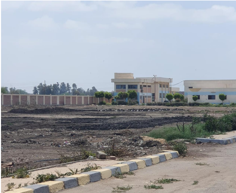
شكل ٩: موقع محطة معالجة الصرف الصحي
